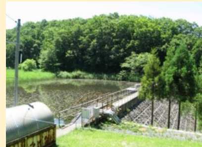
鉱さいたい積場下部（監視測定を行っています）
