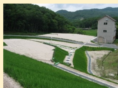
鉱さいたい積場上部（安定化措置後の健全性・有効性を確認中です）
